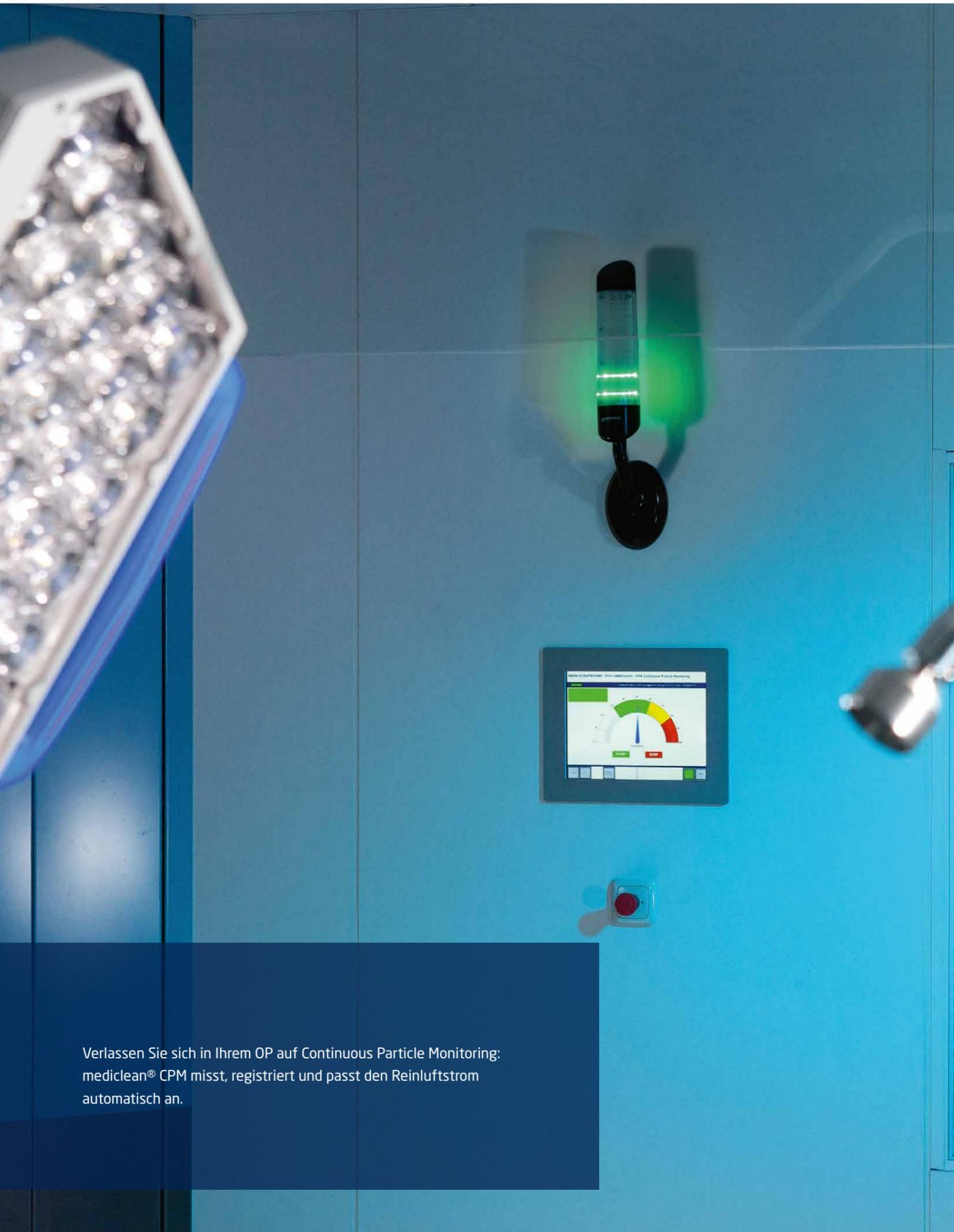
Verlassen Sie sich in Ihrem OP auf Continuous Particle Monitoring: mediclean® CPM misst, registriert und passt den Reinluftstrom automatisch an.
