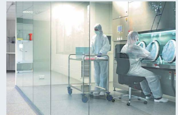
Individuelle Reinraumausrüstung mit Zytostatika-Werkbank, Isolatortechnologie und Materialschleusen
